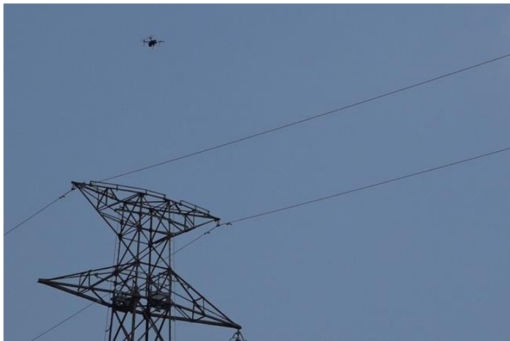
図 2 : 関西電力 能力開発センターの 訓練用の送電線の上空を自動飛行撮影するドローンの様子
