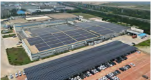
大連アルプスの 太陽光発電設備
