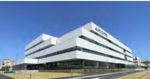
仙台開発センター(古川) R&D新棟
